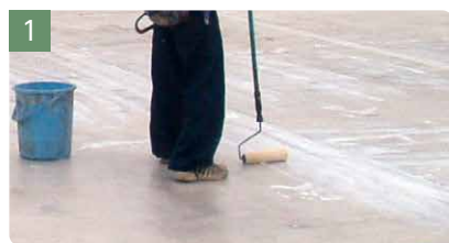
プライマー塗布
