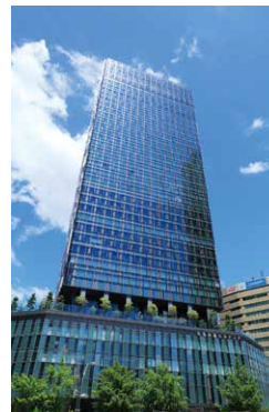
大名古屋ビルヂング
